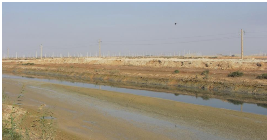
شکل ۸- نمایی از رسوبات جمع شده در کف زهکش GMD-1 در نزدیکی ایستگاه پمپاژ
