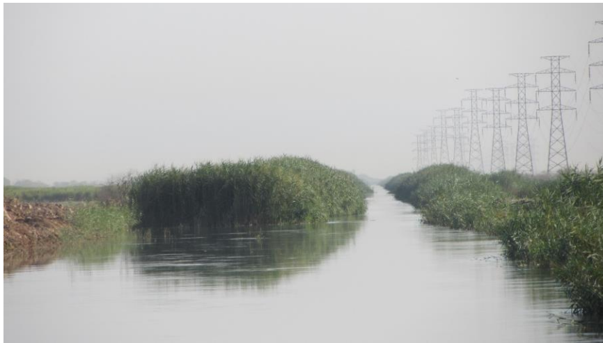
شکل ۱۰- نمایی از رشد علف‌های هرز در زهکش KMD
