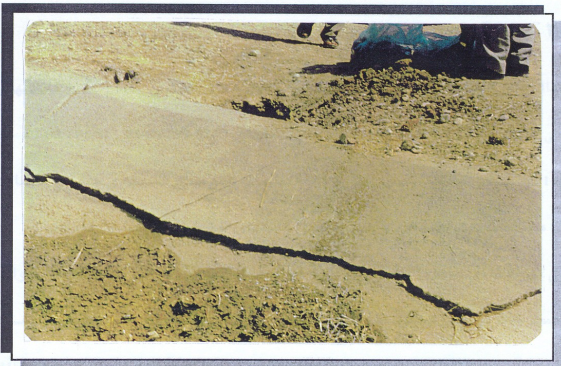
تصویر شماره (۱) - تخریب در کانال PC4 شبکه اوان و نمونه گیری از خاک
