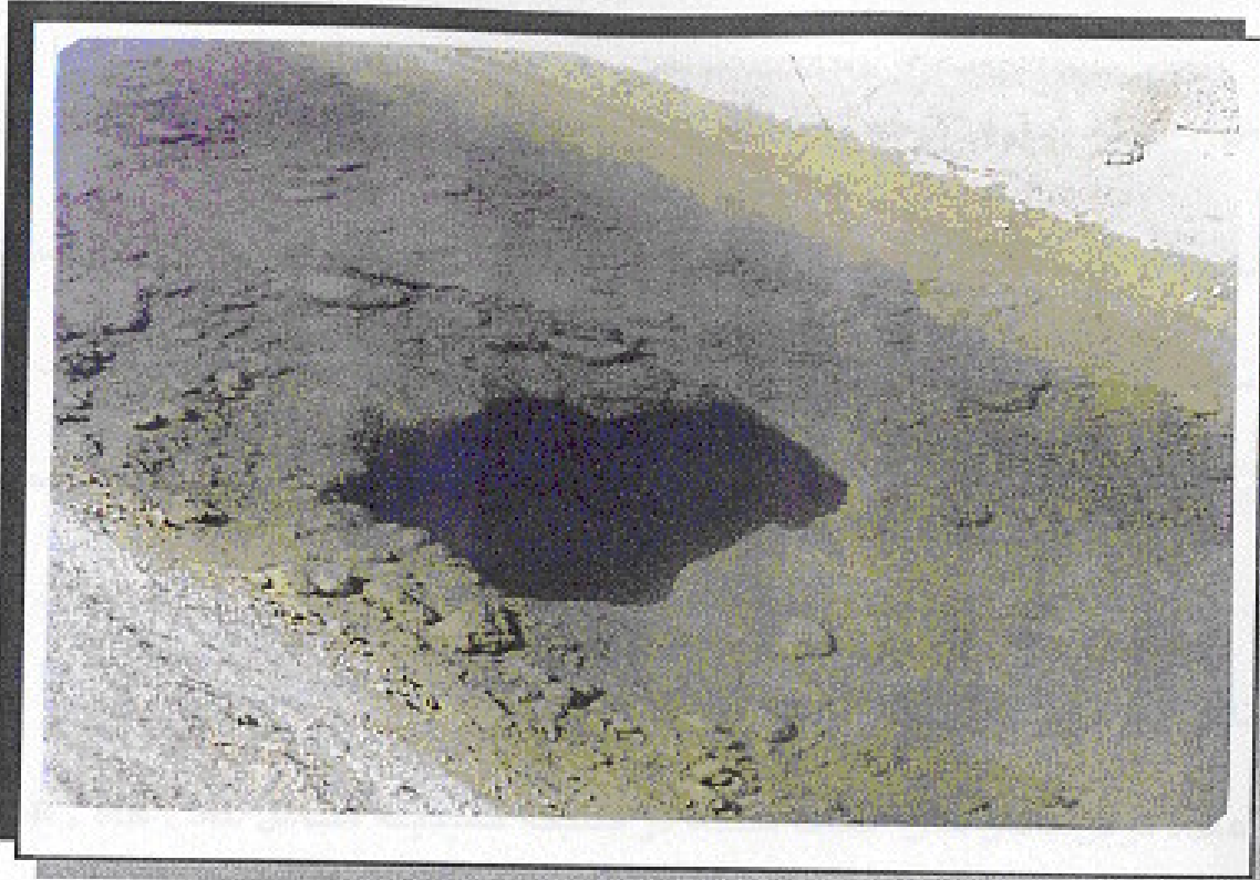
تصویر شماره (۳) - آب شستگی کف کانال A شبکه آبیاری مارون
