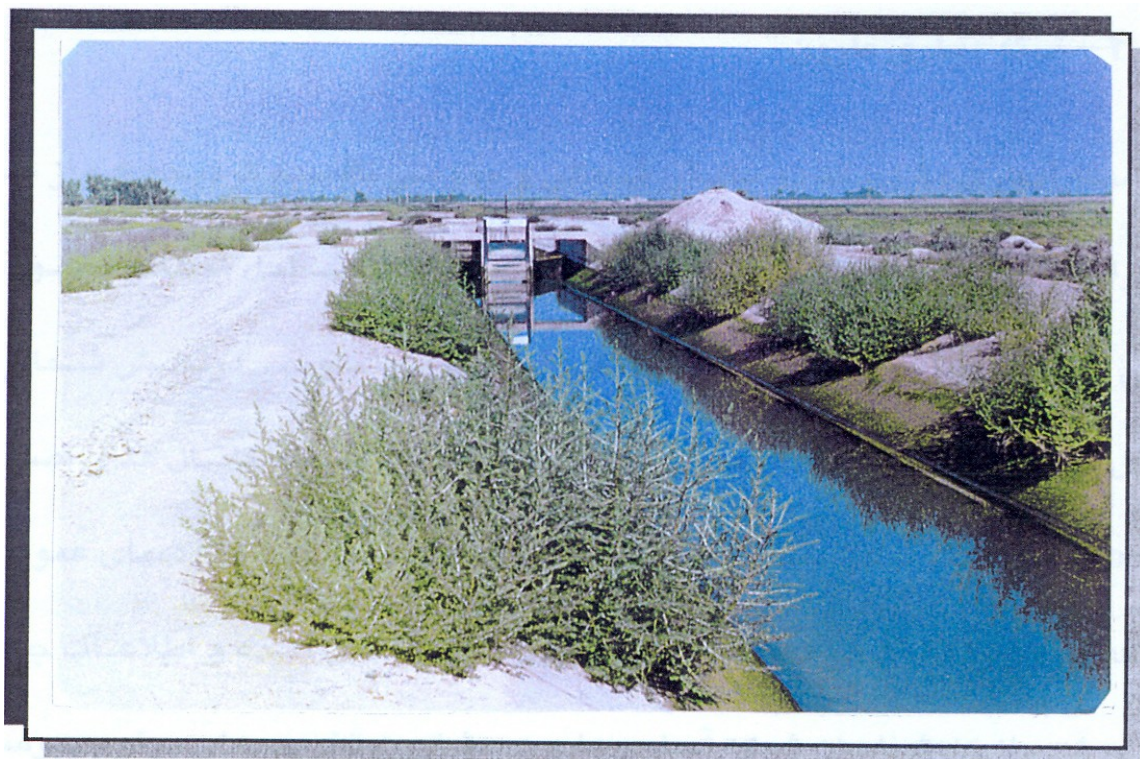
تصویر شماره (۲) - رشد علف های هرز در کانال MS3 شبکه ویس
