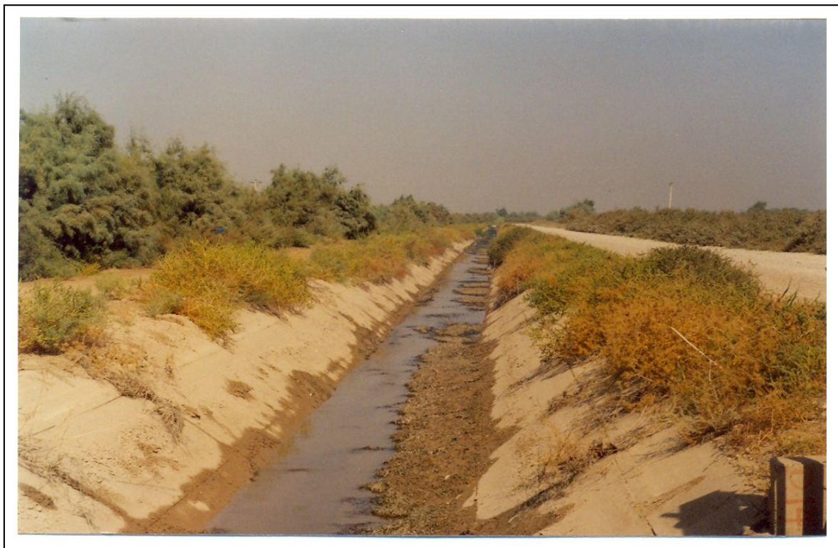
تصویر شماره (۵) - رشد علفهای هرز در کانال D شبکه آبیاری حمیدیه
